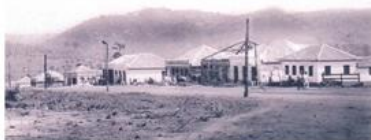
Construções na Av. Hermógenes (Lotes doados pela Comissão Fundadora, com aval da Prefeitura de Goiás). A casa em construção era do Sr. Antônio Silva (pais de Alfonso Pinto Neto), foto de 1951.
